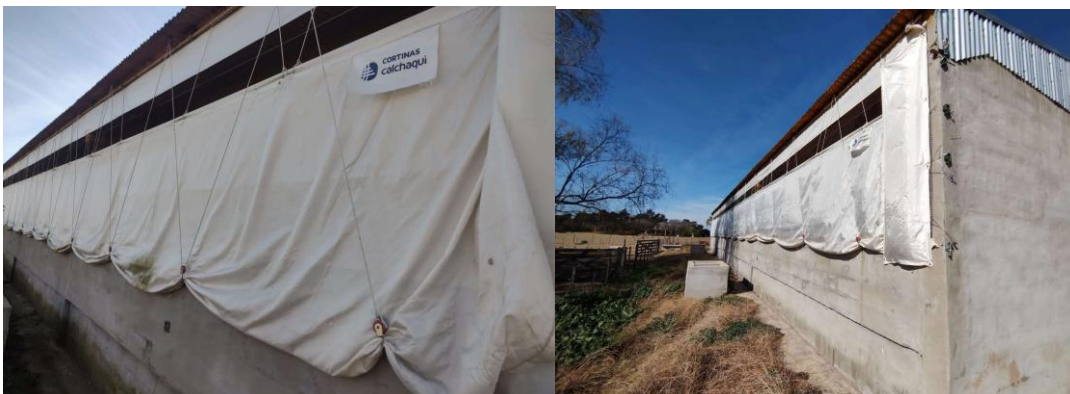
Cortinas del galpón de servicio-gestación y limpieza acondicionamiento de tanque australiano.
